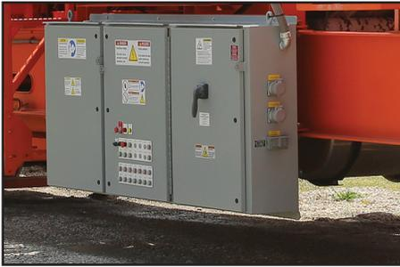
Cuenta con un tablero de control eléctrico removible con tomacorrientes precableados para apiladores radiales.
